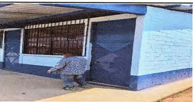
Foto 5: Ventanas, puertas nuevas.
